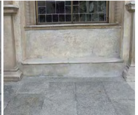
Manutenzione straordinaria intonaco esterno cappella 25 (prima e dopo l'intervento)
